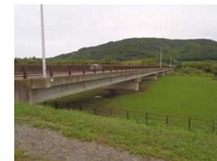
写真-ピスカリ橋（橋長294m）
