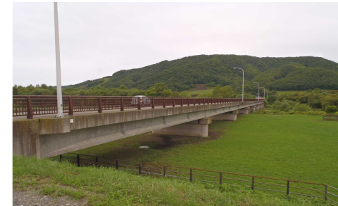
写真-ピスカリ橋 (橋長294m)
